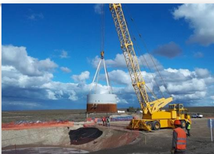
Maniobras de Izaje
