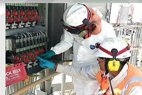
Aislar la fuente de energía
