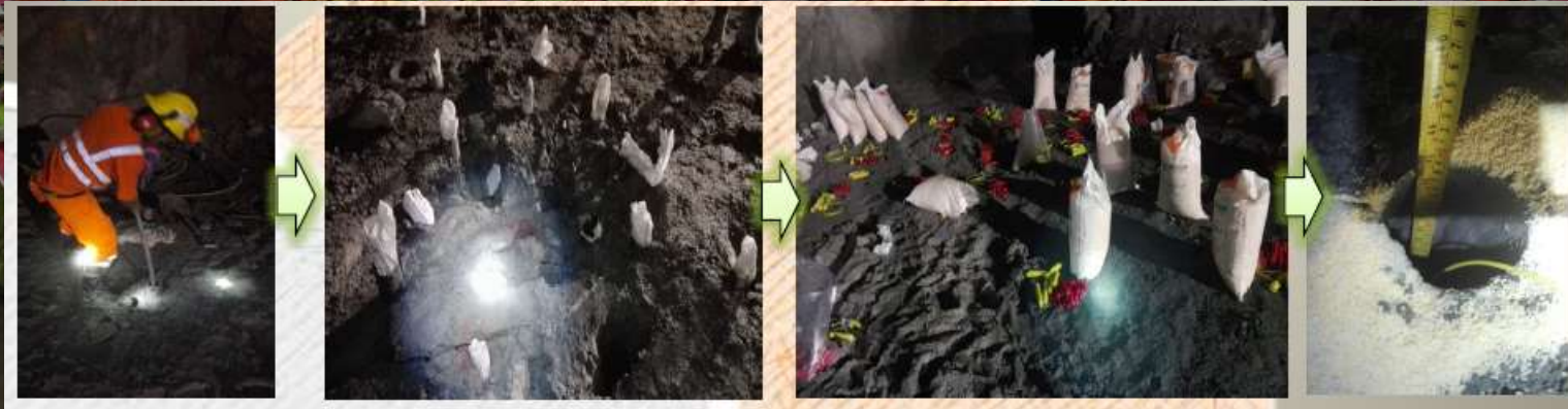
Carguío de Chimenea y Zanja
