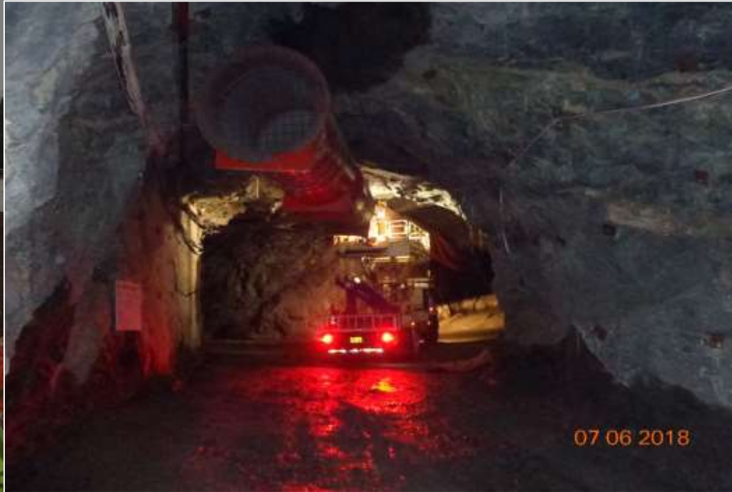
INSTALACIÓN MANGAS - SCISSOR LIFT
