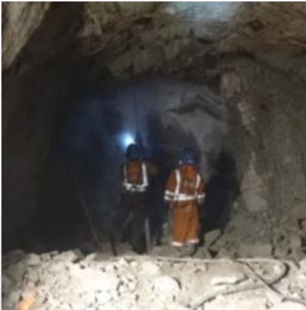
Perforadoras manuales Jack-leg para sostenimiento con pernos y mallas.
