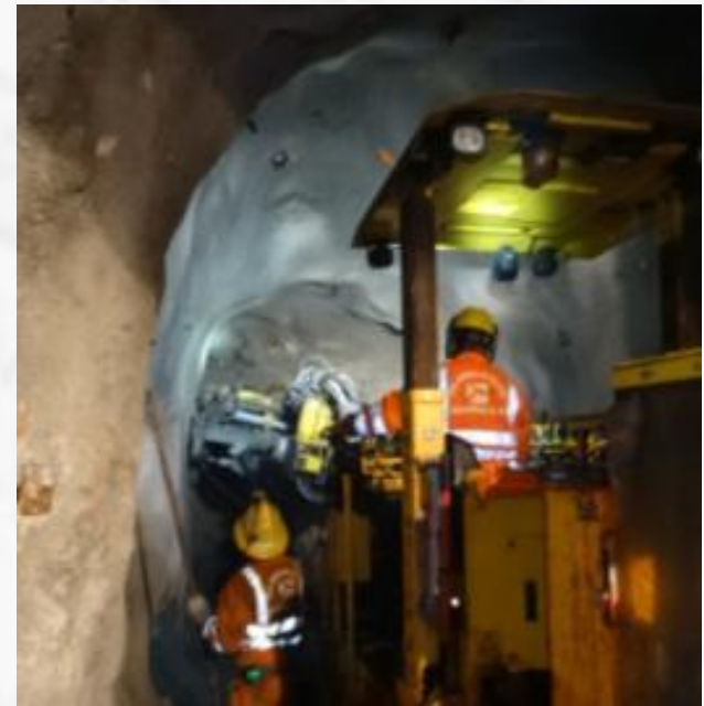
Jumbos empernadores para secciones angostas en el sostenimiento con pernos y mallas.
