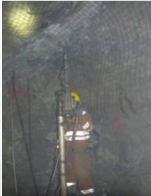
Perforadoras manuales Jack-leg y/o Stoper para frentes y tajos
