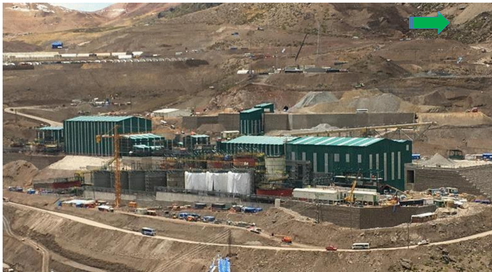
Foto 2: Vista panorámica – TAMBOMAYO FASE 2
