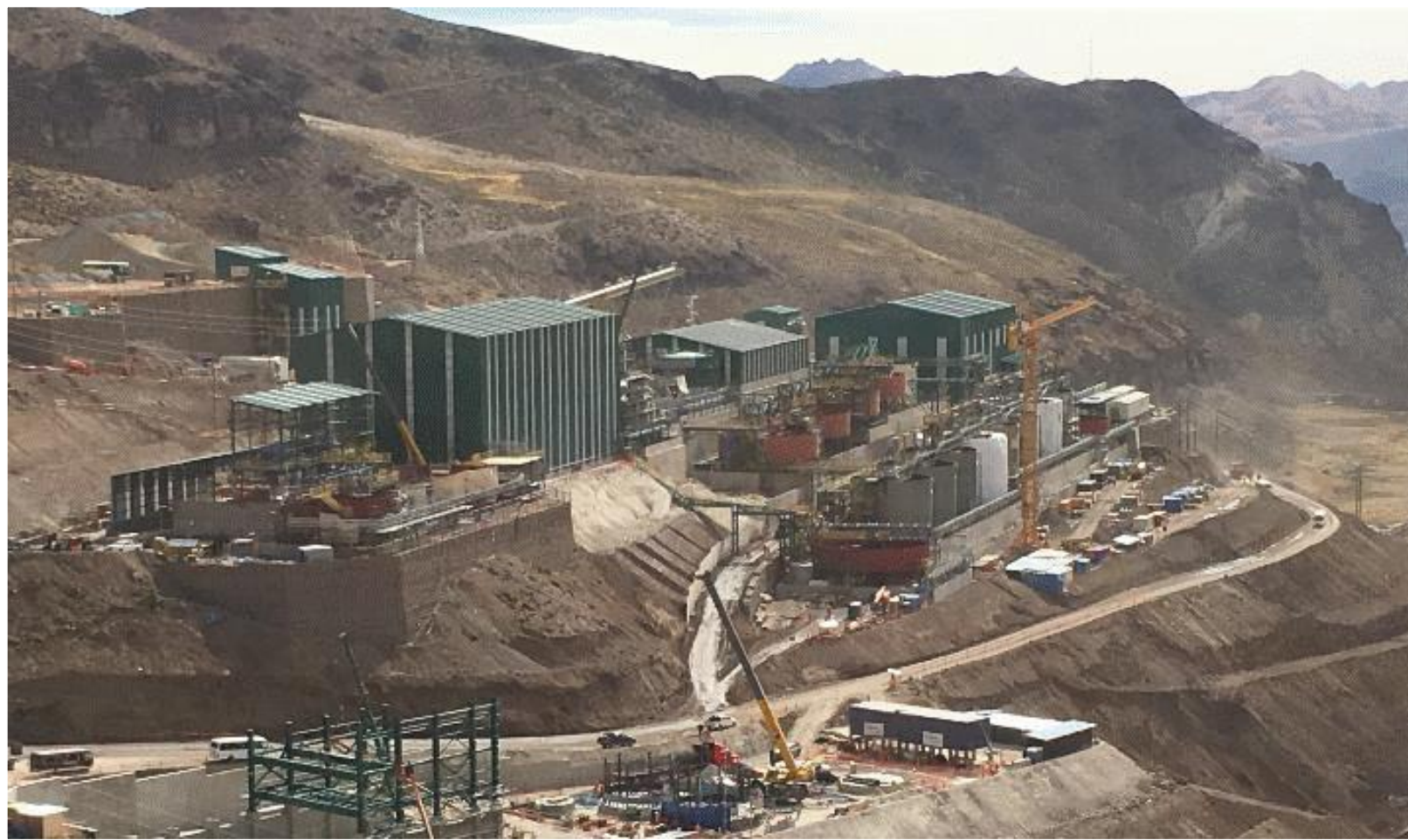
Foto 2: Vista panorámica – TAMBOMAYO FASE 2
