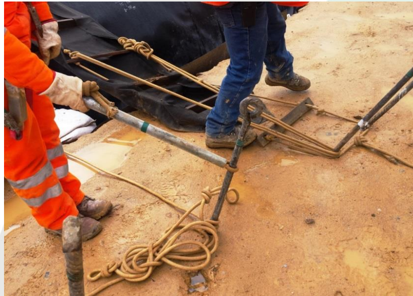
Trabajador retirado en 70 cm de la línea de fuego de la comba
