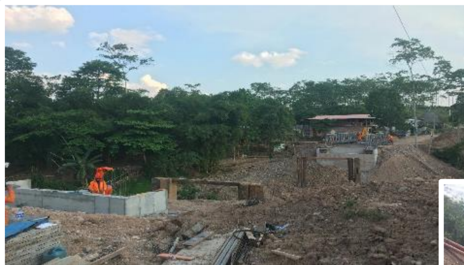
Foto 1: PUENTE MACUYA, MONTAJE DE EM
