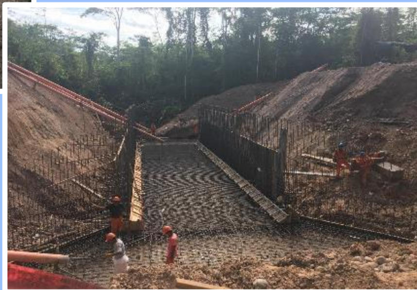
Foto 2: ALCANTARILLA MARCO 46+665 RECBIENDO CONCRETO DE LOSA
