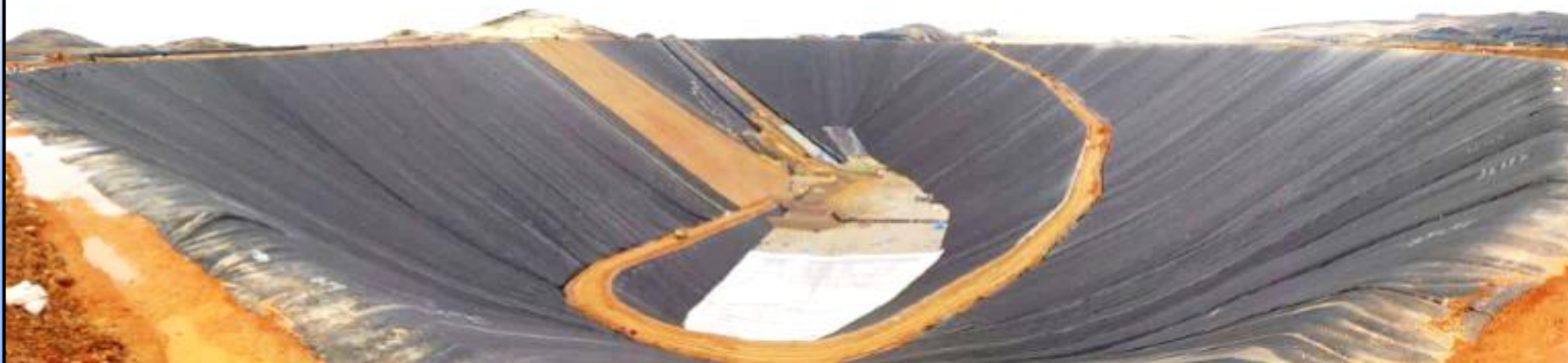
Avance Obra al Cierre SEM 42
