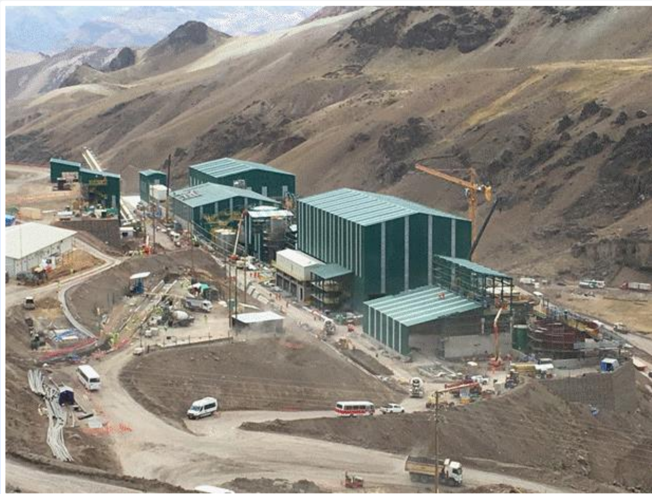
Foto 2: Vista panorámica – TAMBOMAYO FASE 2
