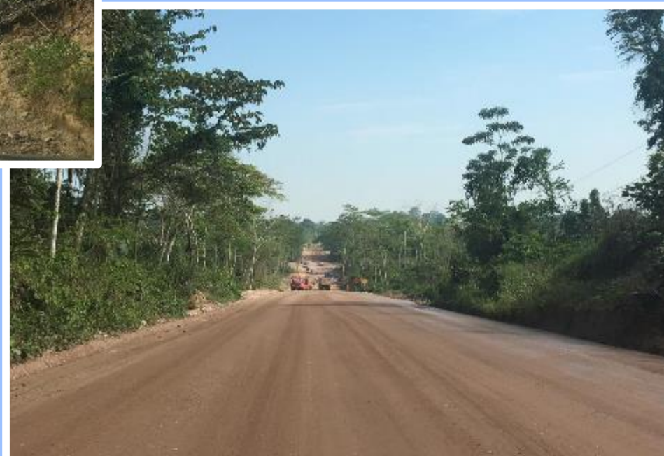
Foto 4: KM 46+260 PRIMERA CAPA DE SUB BASE Y ALCANTARILLA MARCO EN EJECUCION
