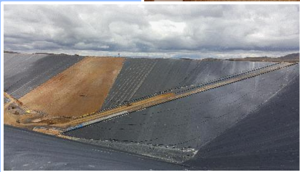
Foto 4&5: MY-DAM - PROCESO DE COLOCACION DE CORREDOR TUBERIAS
