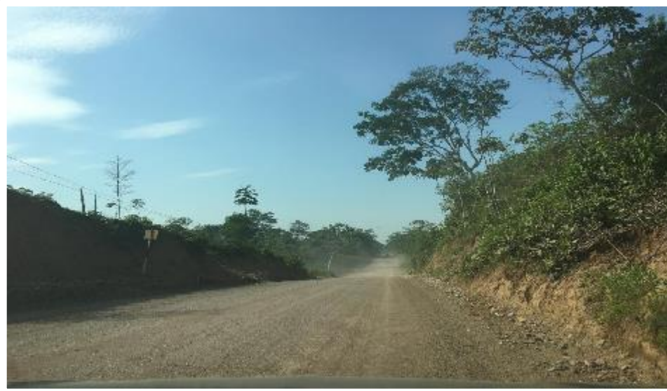
Foto 3: SUBRASANTE, MATERIAL DE SUB BASE COLOCADO
