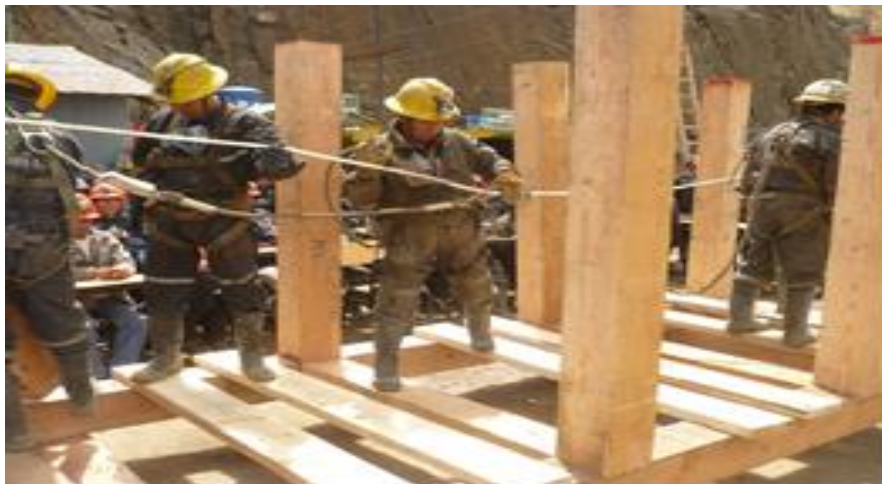
ARMADO DE CUADROS PARA PIQUE
